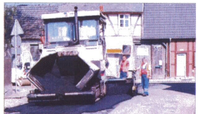
Die Ortsdurchfahrt der Landesstraße 15 in Büste bekommt bis heute Abend eine neue Deckschicht. Foto: Axel Junker
